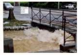
passage du Lanfrey sous la RD 1075 (à coté de la maison de retraite)
