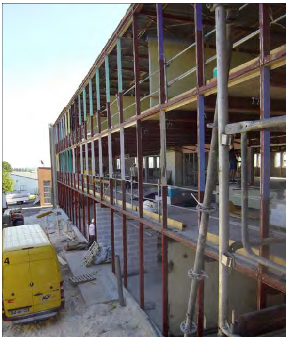
2 - Façade mise à nu
