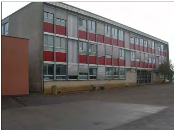
1 - Externat avant travaux
