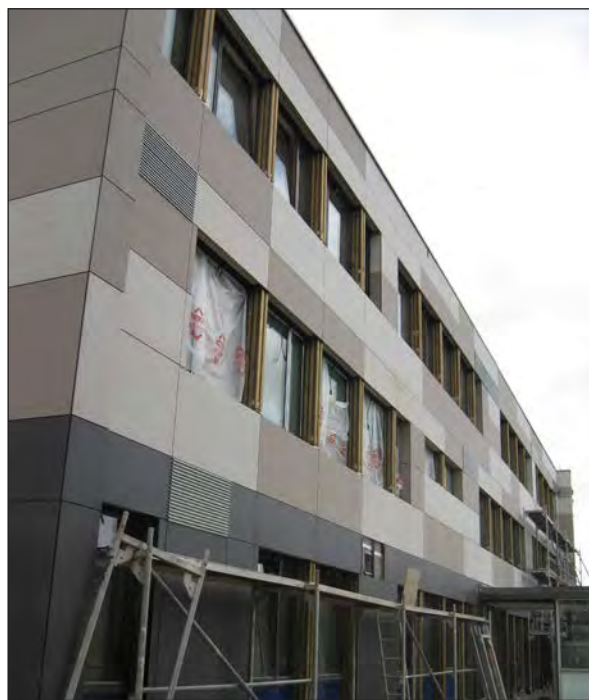
3 - Pose nouvelle façade
