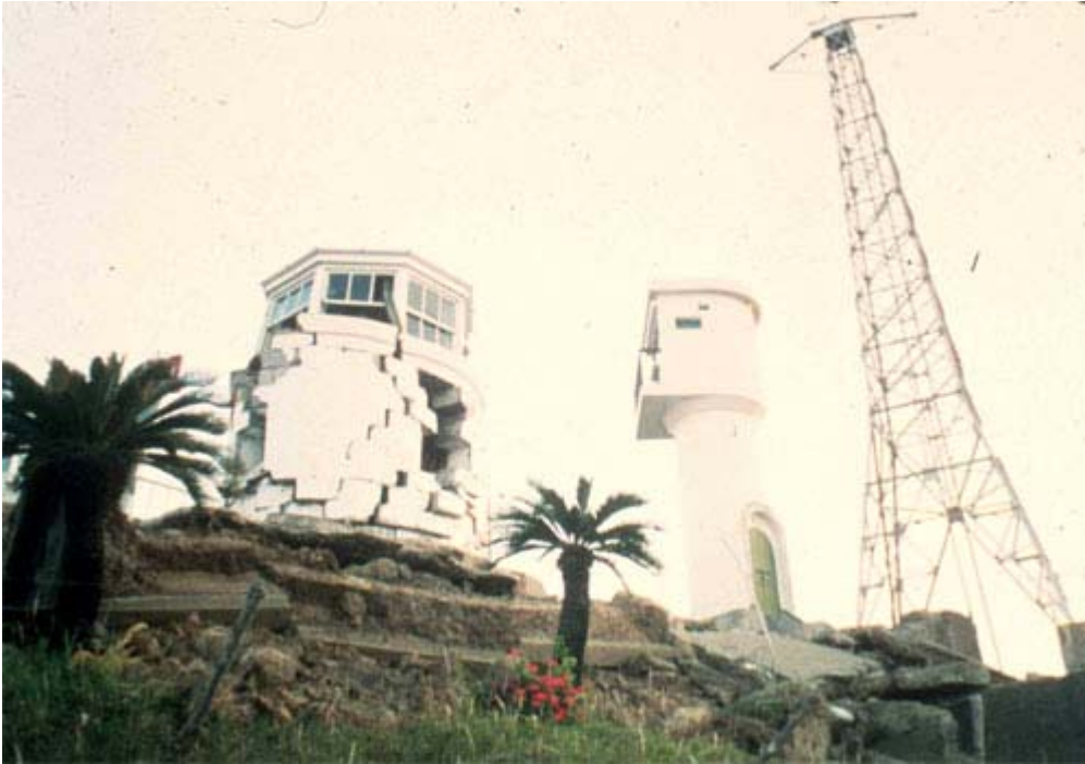
Photo 2 : maçonnerie courbe vulnérable et tour en voile béton armé faisant coque résistante
