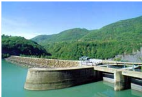
Barrage de Notre Dame de Comniers (38)
