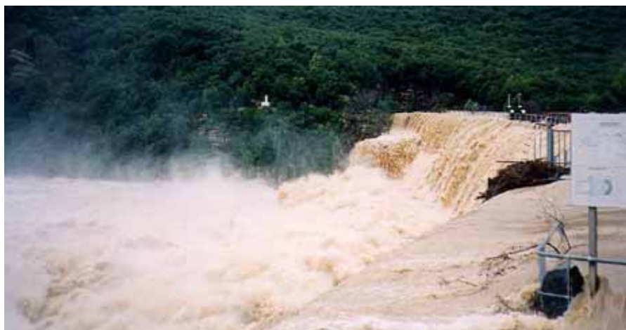
Surverse généralisée du barrage de la Rouvière sur le Crieulon (bassin du Vidourle dans le département du Gard) en septembre 2002. Photo X. Par « chance », l'ouvrage n'a pas cédé.
