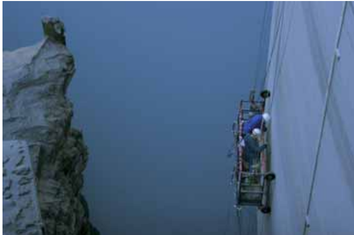
Inspection d'un barrage lors d'une vidange - EDF
