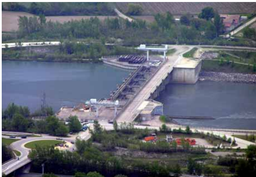
Barrage de St-Egrève - EDF
