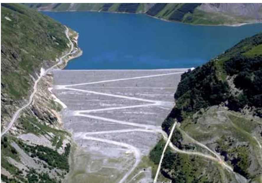
Barrage de Grand'Maison - EDF
