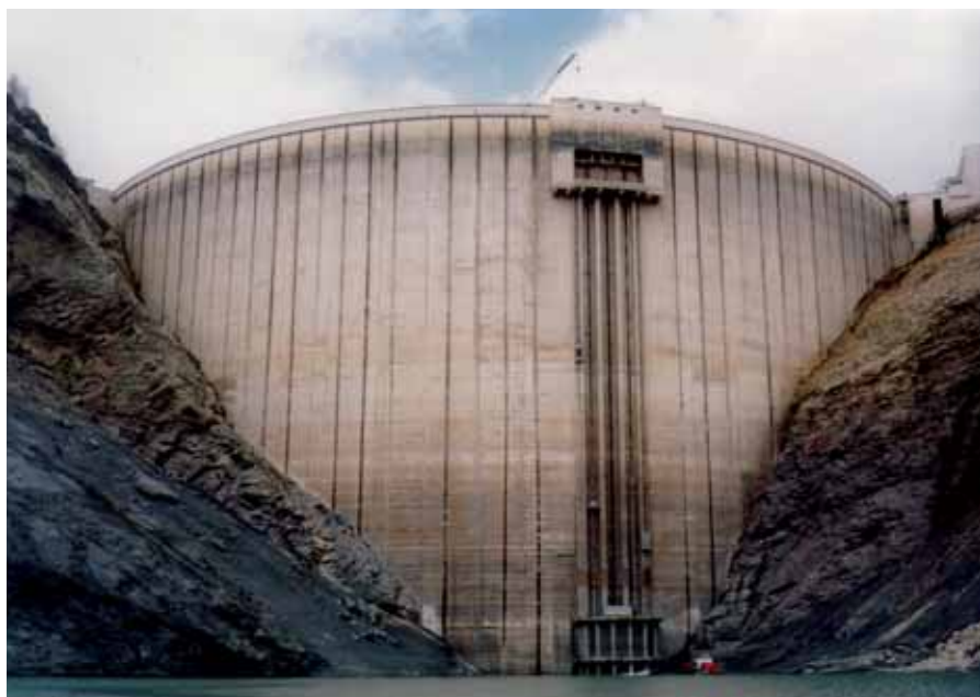
Visite décennale du barrage de Tignes par voie directe après vidange de la retenue - BETCGB
