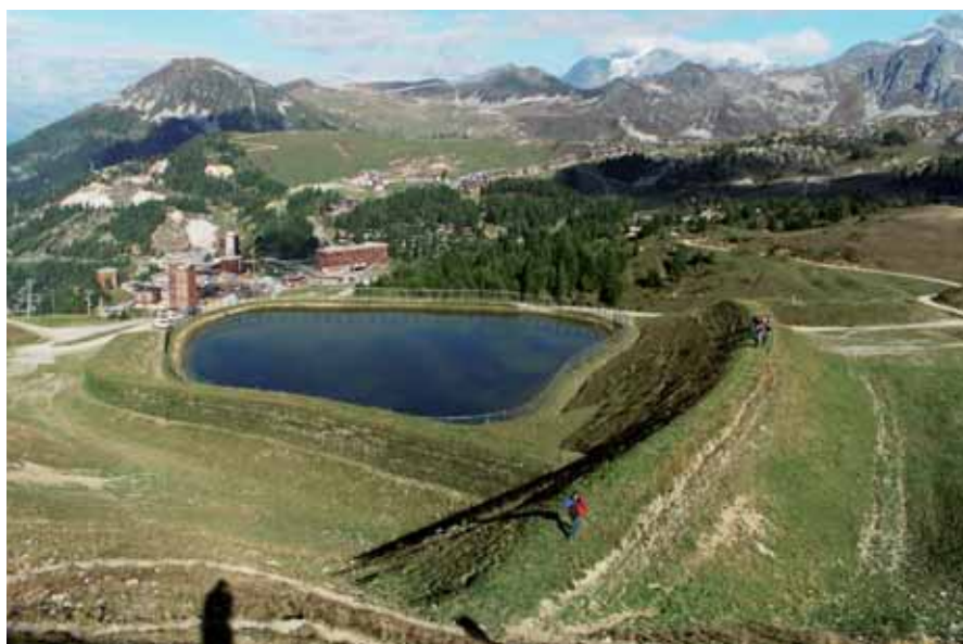
Barrage d'altitude sous protection paravalanche dominant une station de ski - Cemagref
