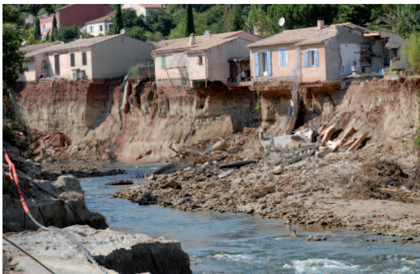
Erosion des berges de la Nartuby lors des inondations du 15 juin 2010 dans le Var / © : IRMa
