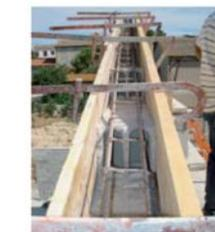
Mise en place d'un chaînage au niveau du rampant d'un bâtiment
