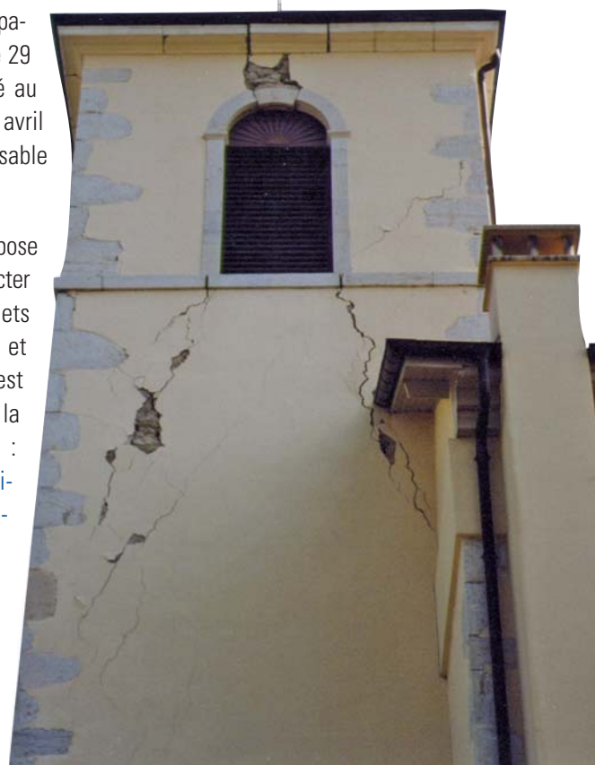
Les dégâts de l'église d'Epagny © Mairie d'Epagny
