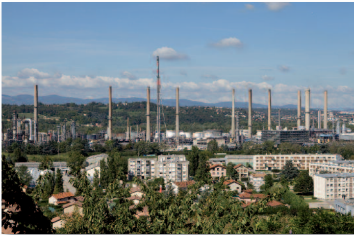
Cohabitation entre ville et industrie dans la Vallée de la Chimie Crédit photo : Grand Lyon – David Desaleux
