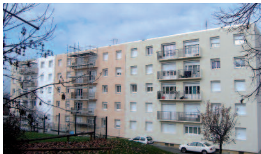
Le RHONE 1 après travaux
