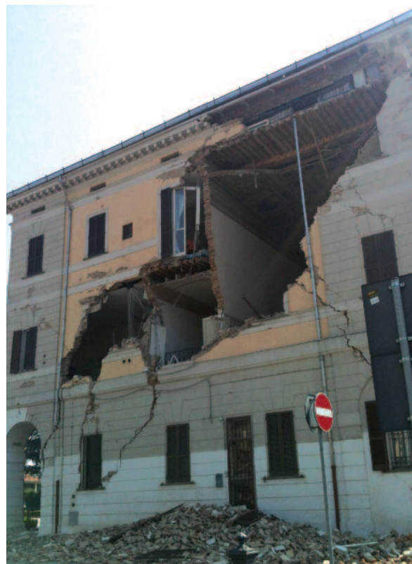
Exemple d'une construction en maçonnerie endommagée lors du tremblement d'Emilia (Italie - 20 mai 2012 - ML 5.9). Pour un séisme modéré, les constructions anciennes subissent de lourds dommages. Ce séisme et ce type de construction sont comparables à ce que l'on peut attendre en France, pays à sismicité modérée.
