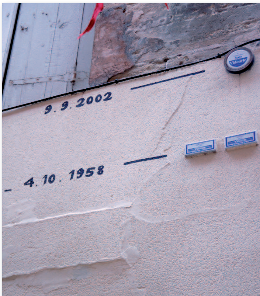
Repères de crues / Sommières (© Institut des Risques Majeurs)
