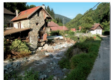
Affouillement en sous-oeuvre - Saint Martin d'Uriage/Domène Août 2005 © Yannick GUIGAL
