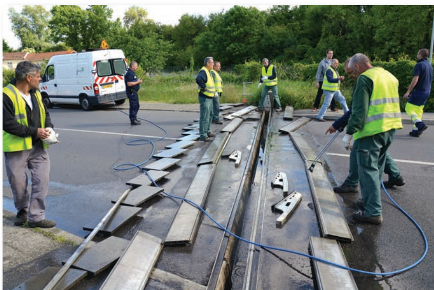
Installation d'un batardeau par les agents communaux au niveau de la cité du Garon - Mai 2014 © Jacques Del Pino (mairie de Givors)
