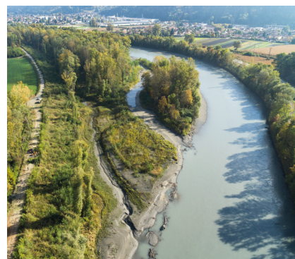
Reconnexion du bras mort de Pré Pichat - 2019 © SYMBHI / PHOTEC
