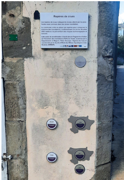
Repères de crues sur la commune de Pennautier - © SMMAR
