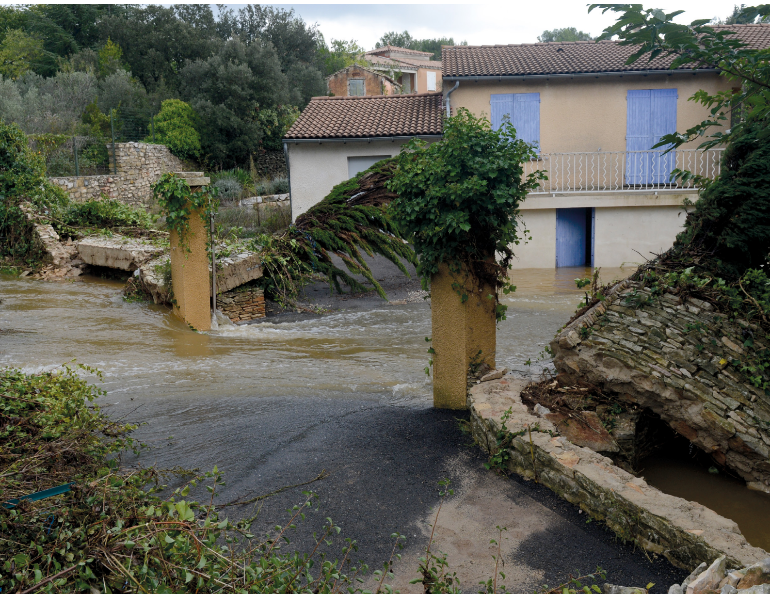
Rue inondée à Nîmes le 10 octobre 2014. © Conseil départemental du Gard.
