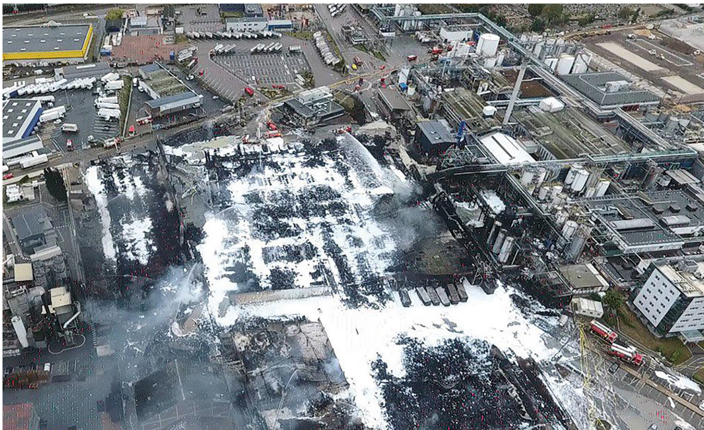
Vue aérienne des dégâts (Incendie de Rouen, septembre 2019) - © SDIS 76
