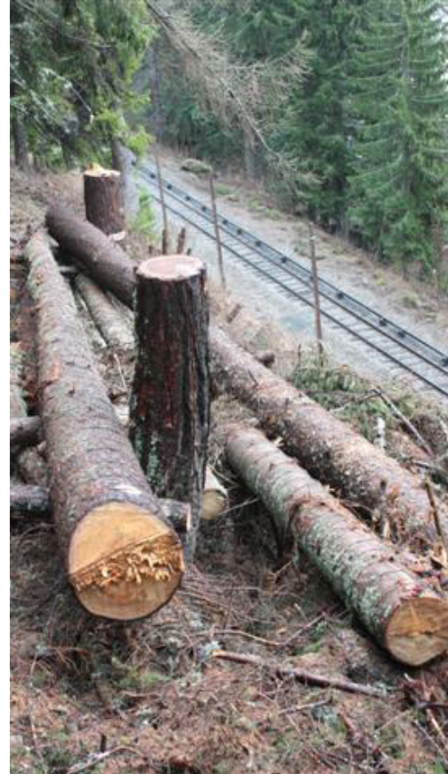
Exemple du chantier de Lioutraz à Argentière (sept. 2010) : la coupe réalisée permet de protéger la voie ferrée des évolutions de terrain (chutes de pierres)
