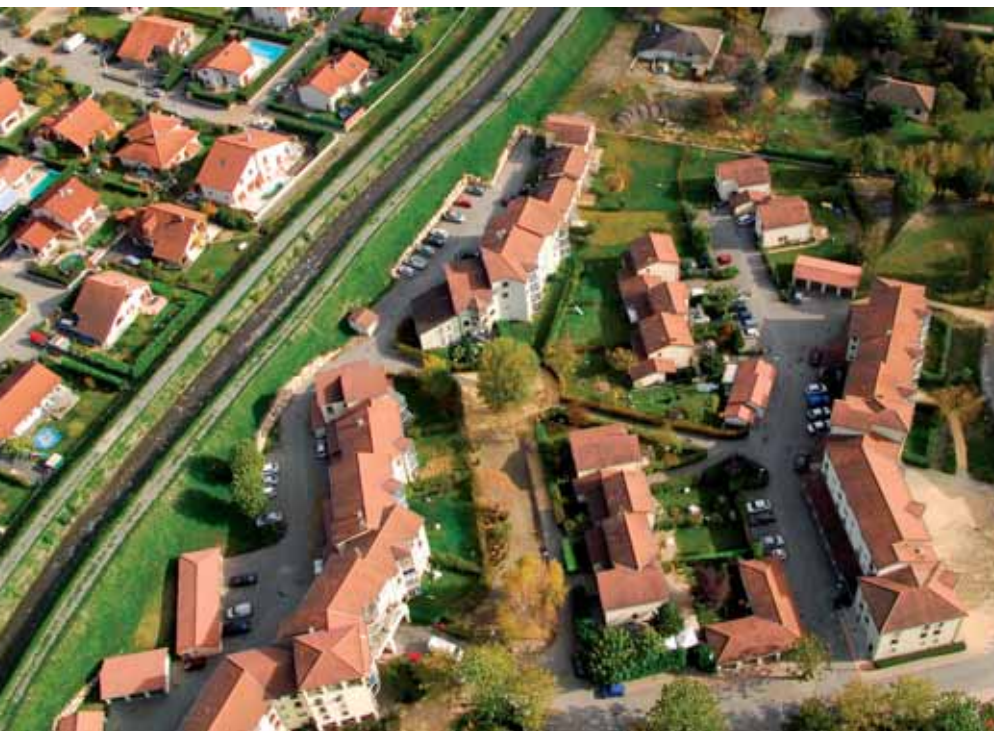
Des immeubles de l'OPAC 38 le long du torrent du Doménon, inondés en août 2005
