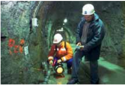
Lecture d'un piézomètre (contrôle intégré à l'ouvrage) - EDF
