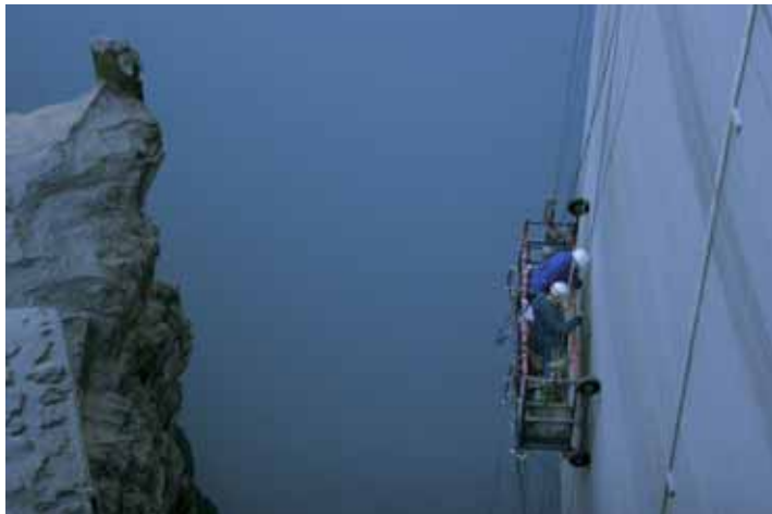
Inspection d'un barrage lors d'une vidange - EDF
