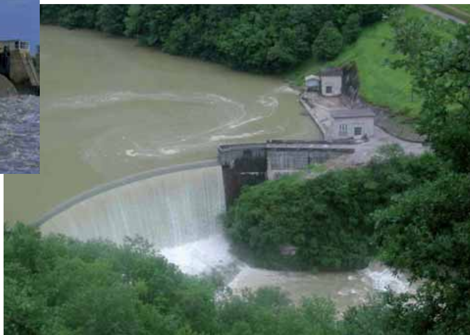
Déversement du barrage de Choranche - EDF
