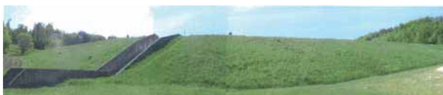
Barrage de Roybon - DDAF Isère
