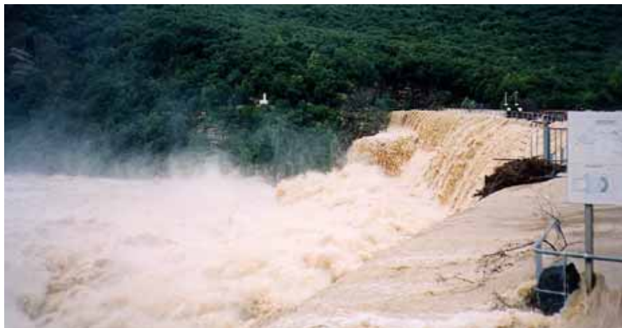
Surverse généralisée du barrage de la Rouvière sur le Crieulon (bassin du Vidourle dans le département du Gard) en septembre 2002. Photo X. Par « chance », l'ouvrage n'a pas cédé.
