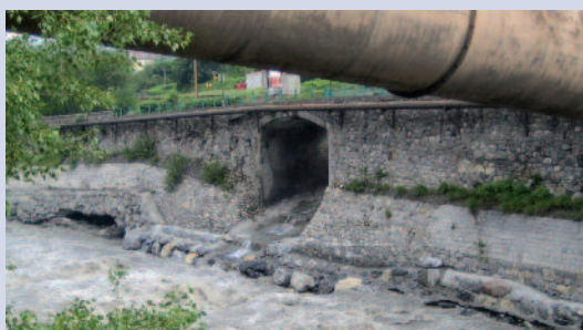
Le déficit sédimentaire et la fixation des berges, qui empêche toute recharge latérale, engendrent l'érosion du fond du lit jusqu'à la destruction des ouvrages de protection (crédit photo : SPM : l'Arc à St Julien-Montdenis après la crue du 29 mai 2008)
