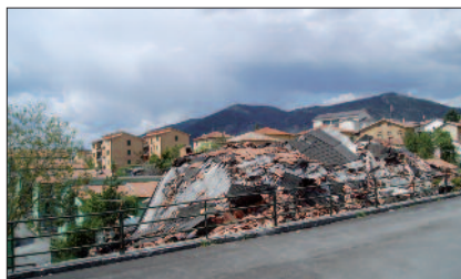
© L'Aquila - un immeuble, qui venait d'être restauré, totalement effondré. Derrière, des immeubles identiques, intacts (photo M.Givry)
