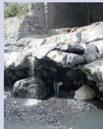
Le déficit sédimentaire et la fixation des berges, qui empêche toute recharge latérale, engendrent l'érosion du fond du lit jusqu'à la destruction des ouvrages de protection (crédit photo : SPM : l'Arc à St Julien-Montdenis après la crue du 29 mai 2008)
