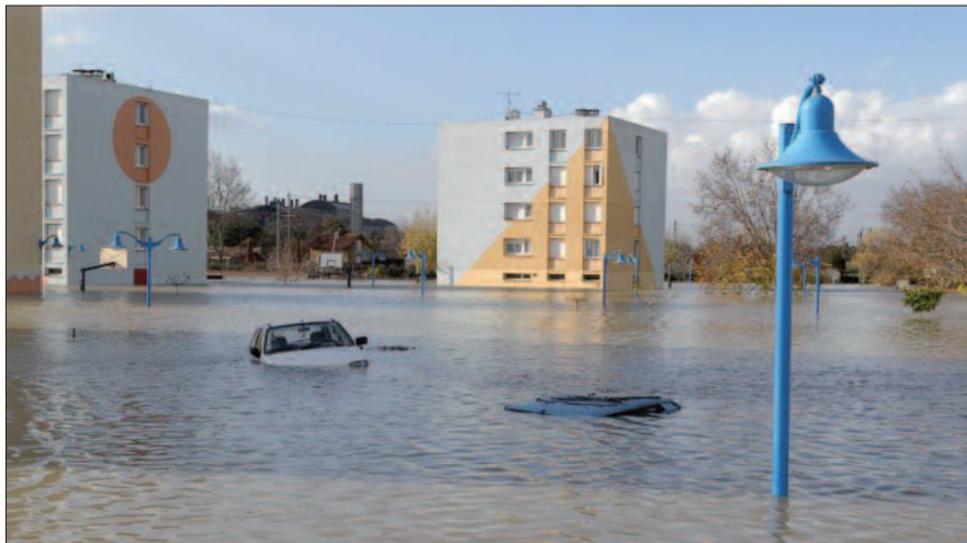
© Inondation du Gard - Septembre 2002 - Immeubles inondés à Laudun l'Ardoise - CG 30
