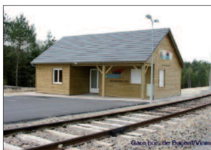
© stockage et évacuation du bois Crédits photos : EDF, Météo France, Arte
