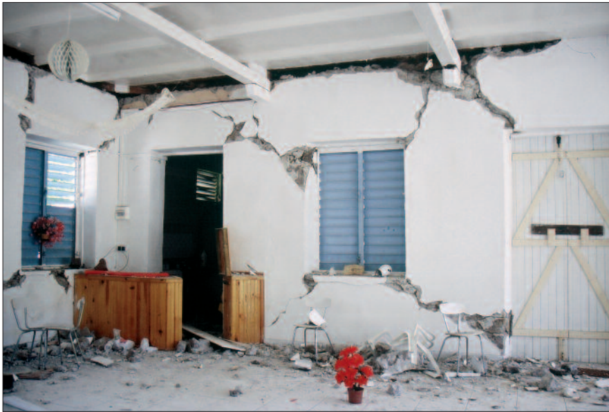
© Séisme des Saintes – Novembre 2004 – Une habitation en partie endommagée – Guadeloupe – Boutin AFPS
