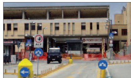
© L'Aquila - l'Hôpital endommagé et évacué (photo M.Givry - 1 mois après le séisme)
