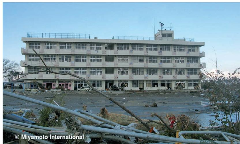
Ecole Elémentaire municipale à Arahama (Sendai) ayant survécu aux vibrations et au tsunami (malgré une submersion des deux premiers étages) : le bâtiment avait été renforcé avant le séisme et n'a subi aucun dommage structural.
