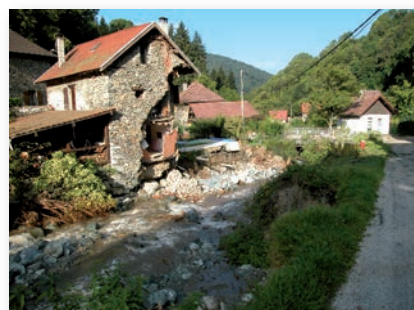
Affouillement en sous-œuvre - Saint Martin d'Uriage/Domène Août 2005 © Yannick GUIGAL
