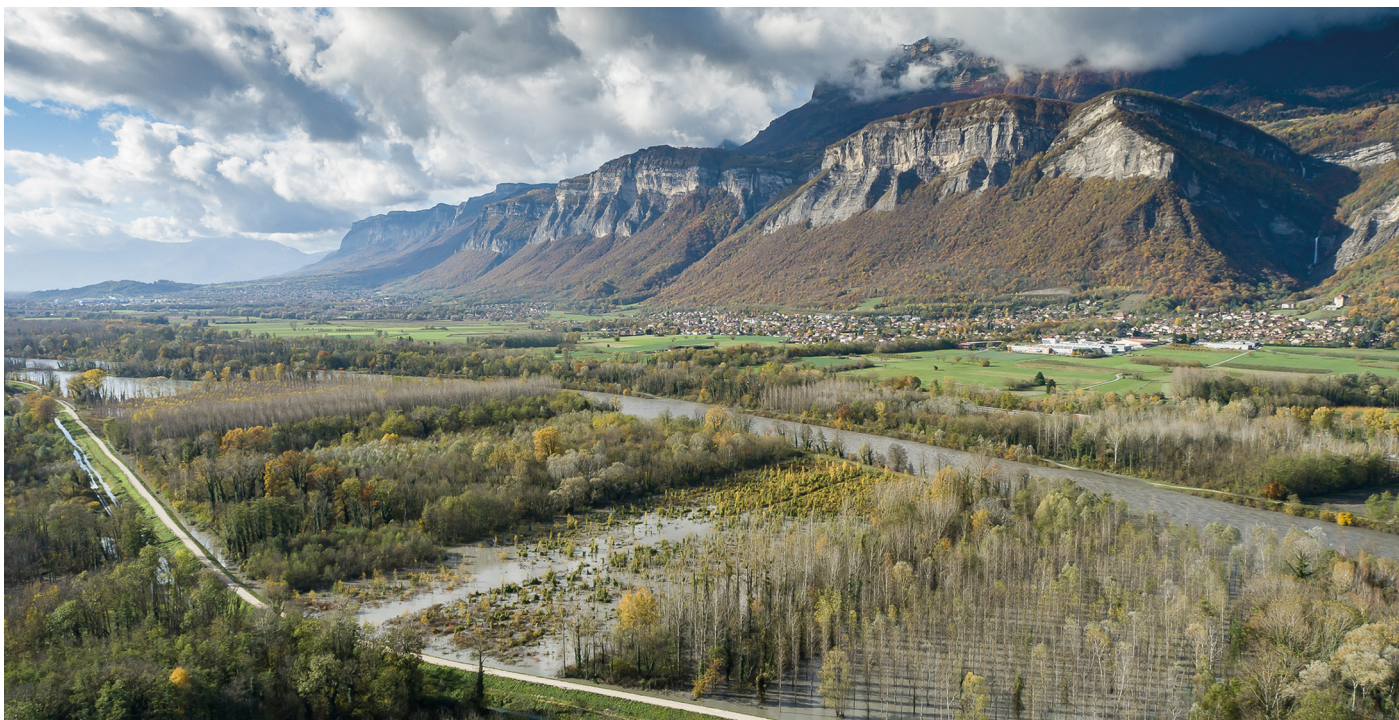
Photo 1 : zone de recul de digues et mise en eau des forêts alluviales lors de la crue du 15 novembre 2023 - © Dupont-Renoux
