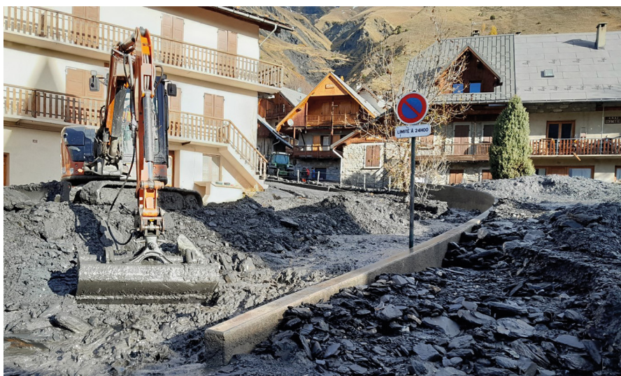
Curage d'urgence du chenal du ruisseau de l'Église à Saint-Sorlin-d'Arves le 15/11/2023 vers 10h © ONF-RTM
