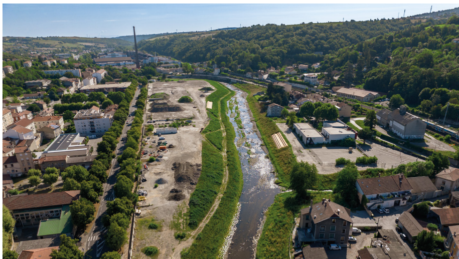
Le Gier au droit de l'ancienne verrerie à Rive-de-Gier après l'aménagement - ©SEM
